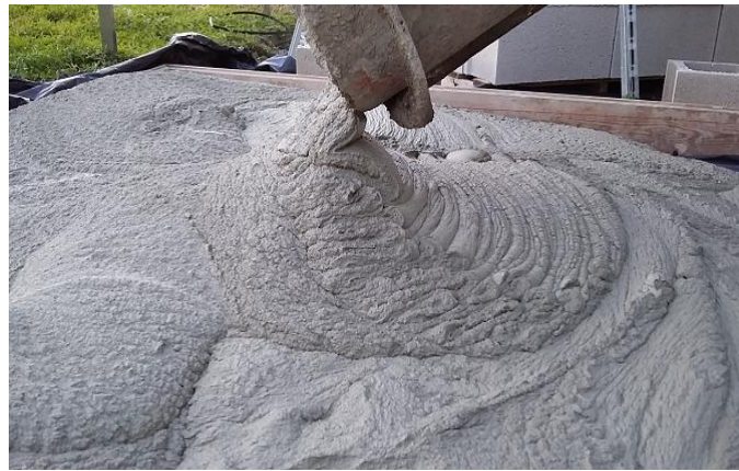
Figura 5.- Detalle de Mortero Celular fabricado con uso de aditivo espumante. Alta oclusión de aire, obtención de mortero de baja densidad.
